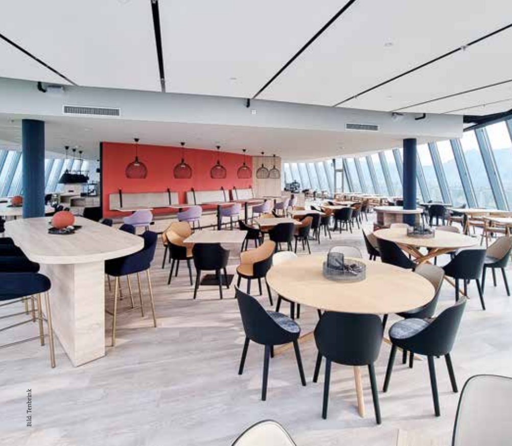
Rundumblick im Restaurant auf die Alpen und den Bodensee. Die Kühlsegel an der Rohdecke wurden eigens für das Projekt entworfen.
