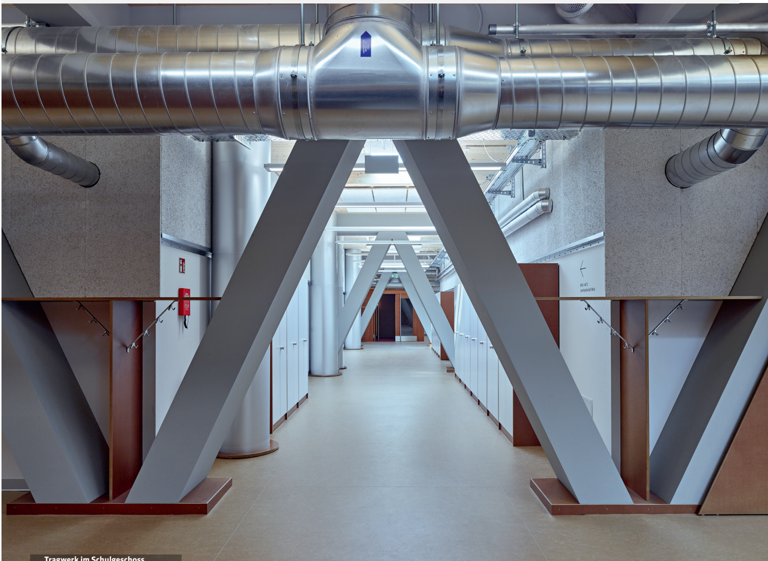
Tragwerk im Schulgeschoss
