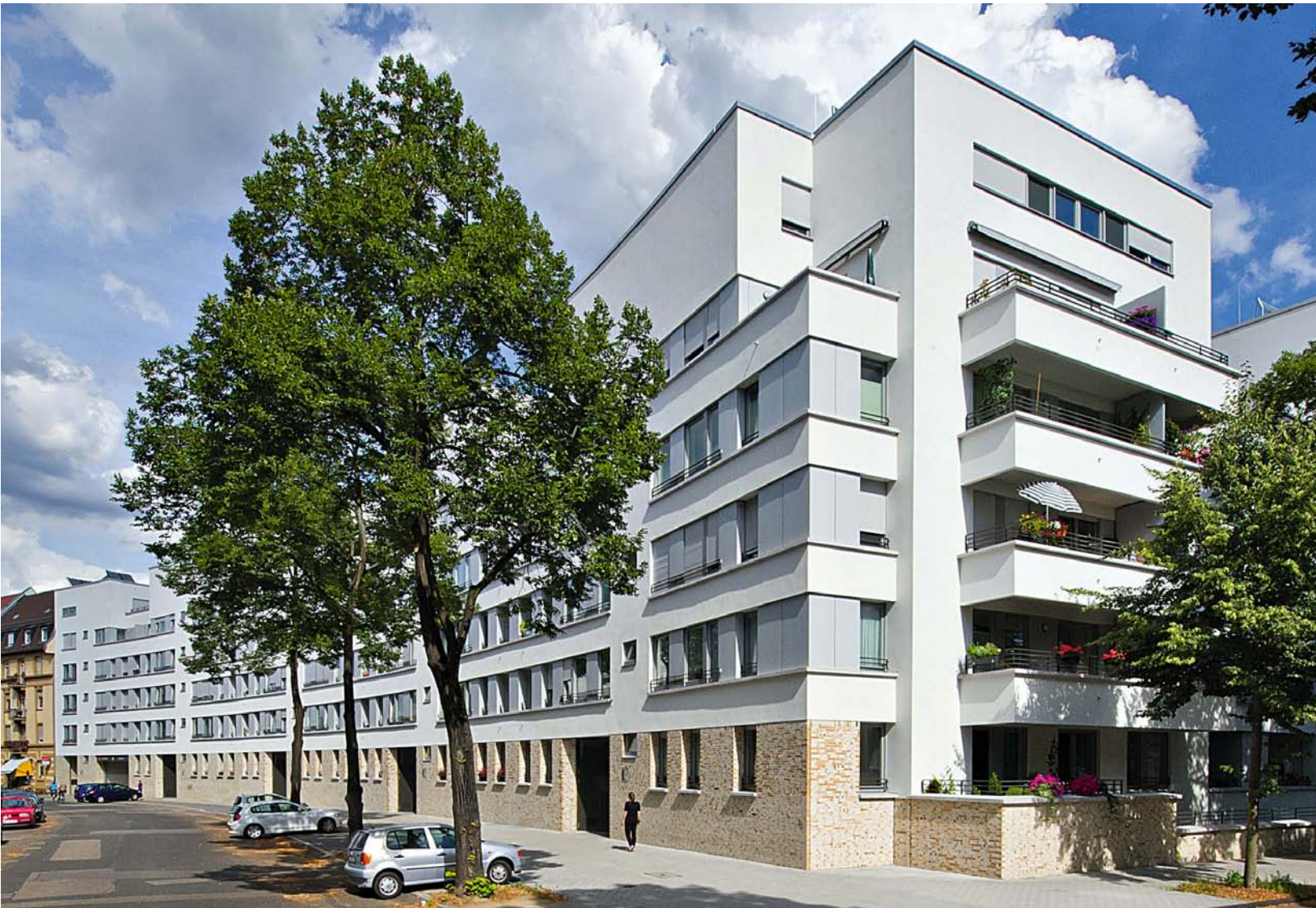
Die Gestaltung der Fassaden mit Klinker im Erdgeschoss und Fensterbänken aus Betonwerkstein greift Elemente der umgebenden Bebauung auf.
